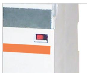
На лицевой панели выключателя контактора реализован **механический индикатор положения контактов** (включено/отключено).
